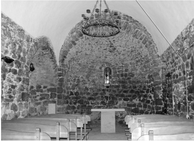
Interior de la Capella de Vall de Maria un cop acabada la rehabilitació.
