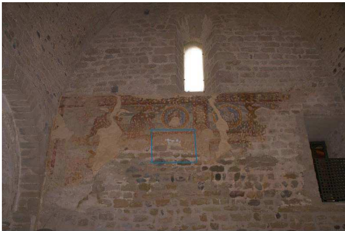
Vista de la zona afectada emmarcada en blau
