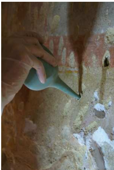
Eliminació d'aire i de restes de sorra no cohesionades de l'interior de les bosses.
